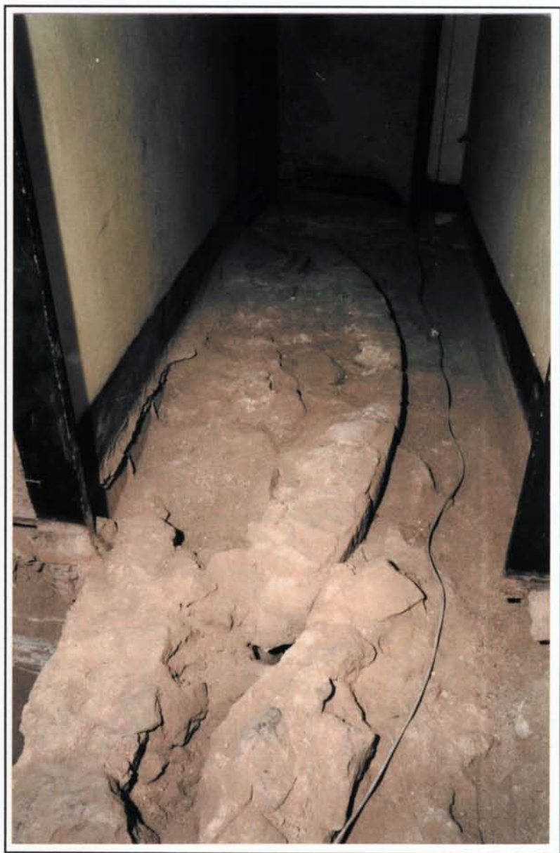
Foto 15. Planta principal. Cala damunt la capella. Detall anella torre primitiva (foto R.Muro).
