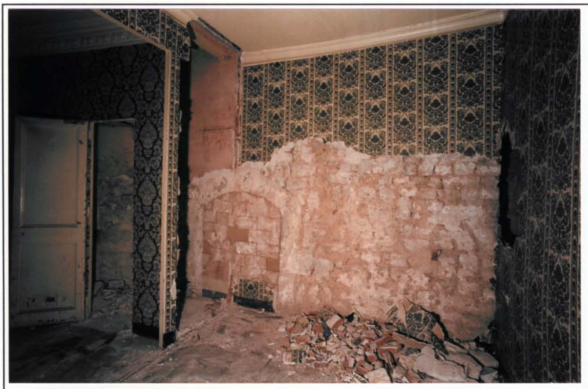
Foto 18. Planta primera. Parament contigüu Pati d'en Llimona (foto R.Muro).
