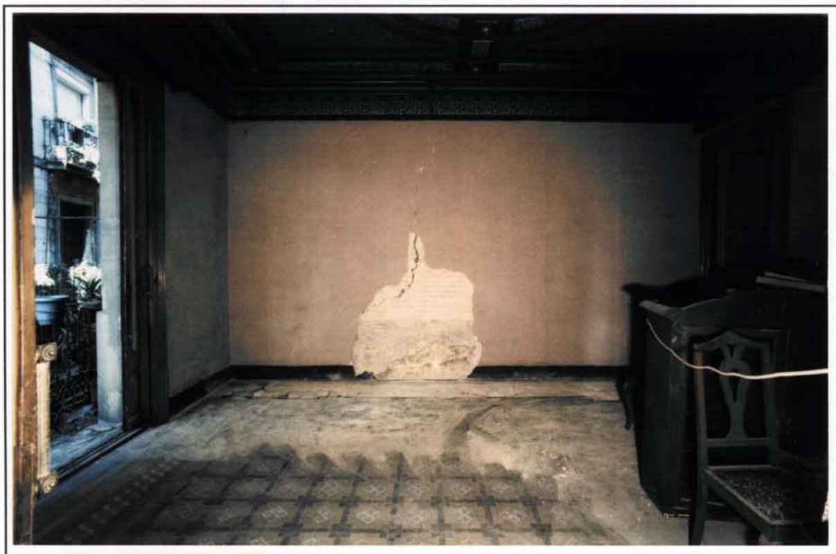
Foto 16. Planta principal. Muralla i remunta de paret de maó (foto R.Muro).
