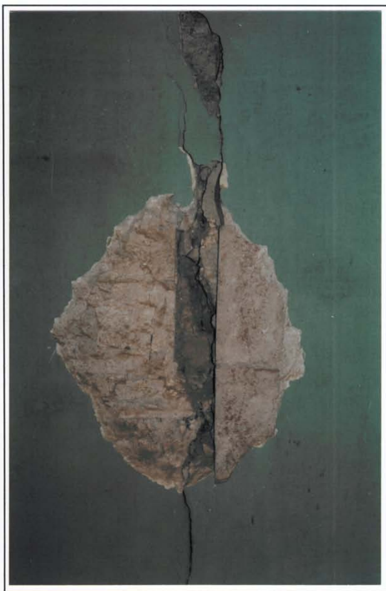
Foto 13. Planta entresol. Parament de la mitgera amb Regomir-11. Detall esquerra (foto R.Muro).
