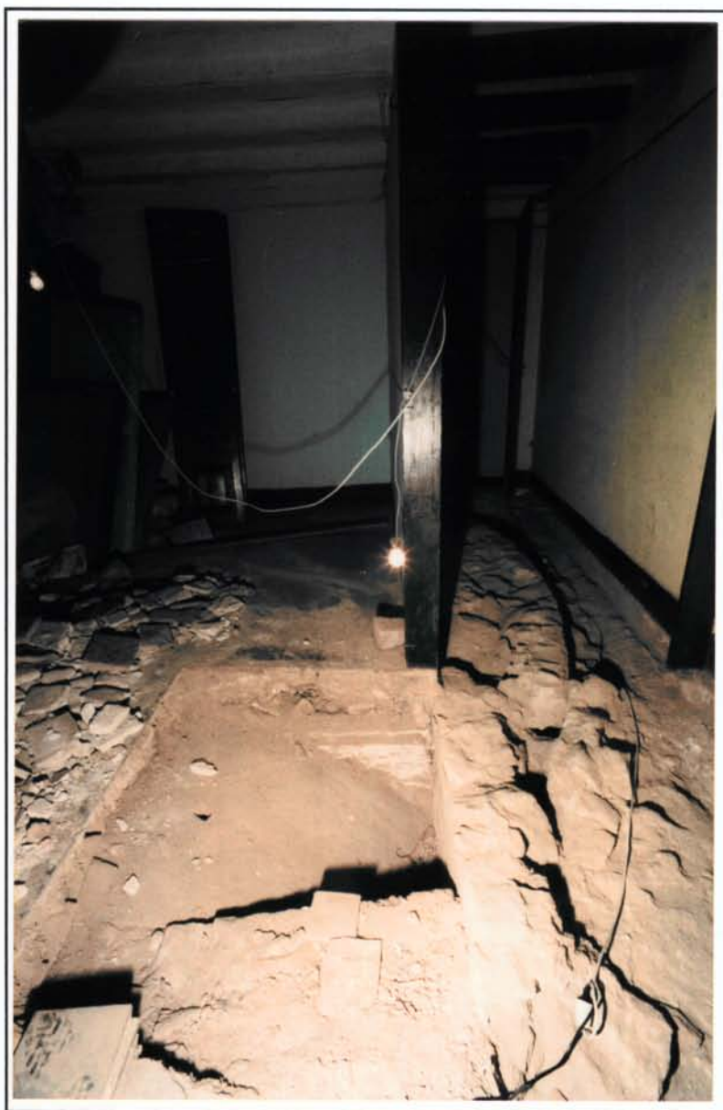
Foto 14. Planta principal. Cala damunt de la capella. Vista de l'extrados de la volta i anella torre (foto R.Muro).
