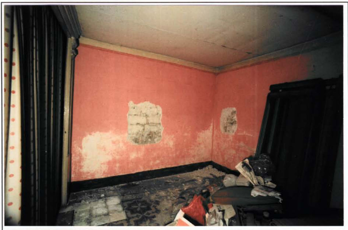
Foto 11. Planta entresol. Parament de la mitgera amb Regomir-11 (foto R.Muro).
