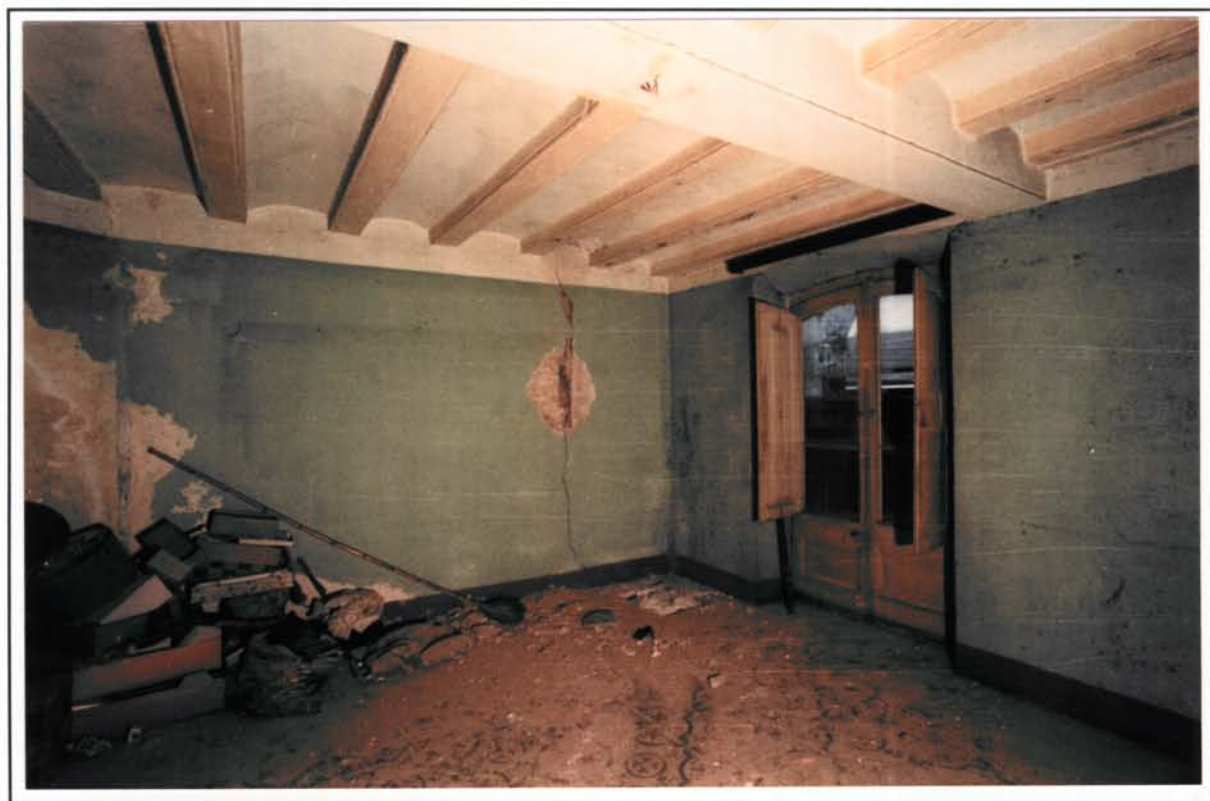
Foto 12. Planta entresol. Parament de la mitgera amb Regomir-11 (foto R.Muro).
