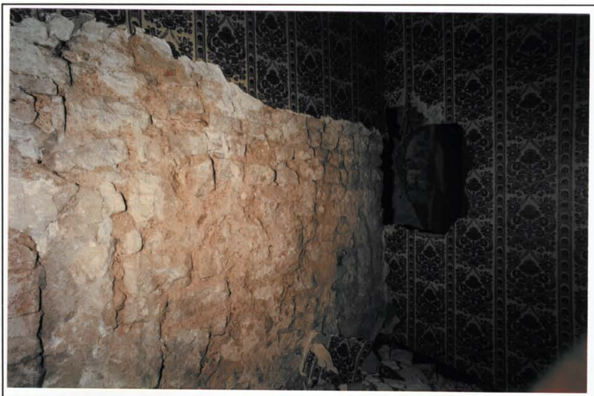
Foto 20. Planta primera. Parament contigüu Pati d'en Llimona (foto R.Muro).
