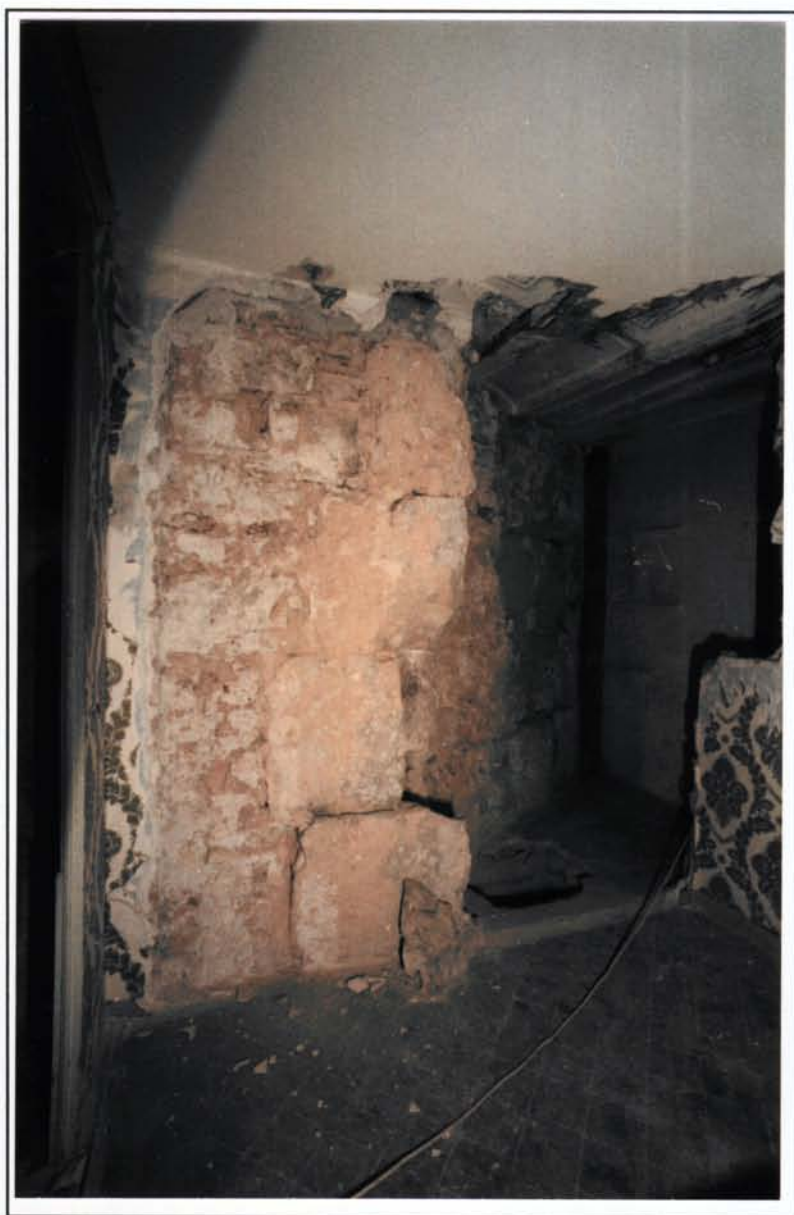
Foto 10. Planta entresol. Parament torre (foto R.Muro).
