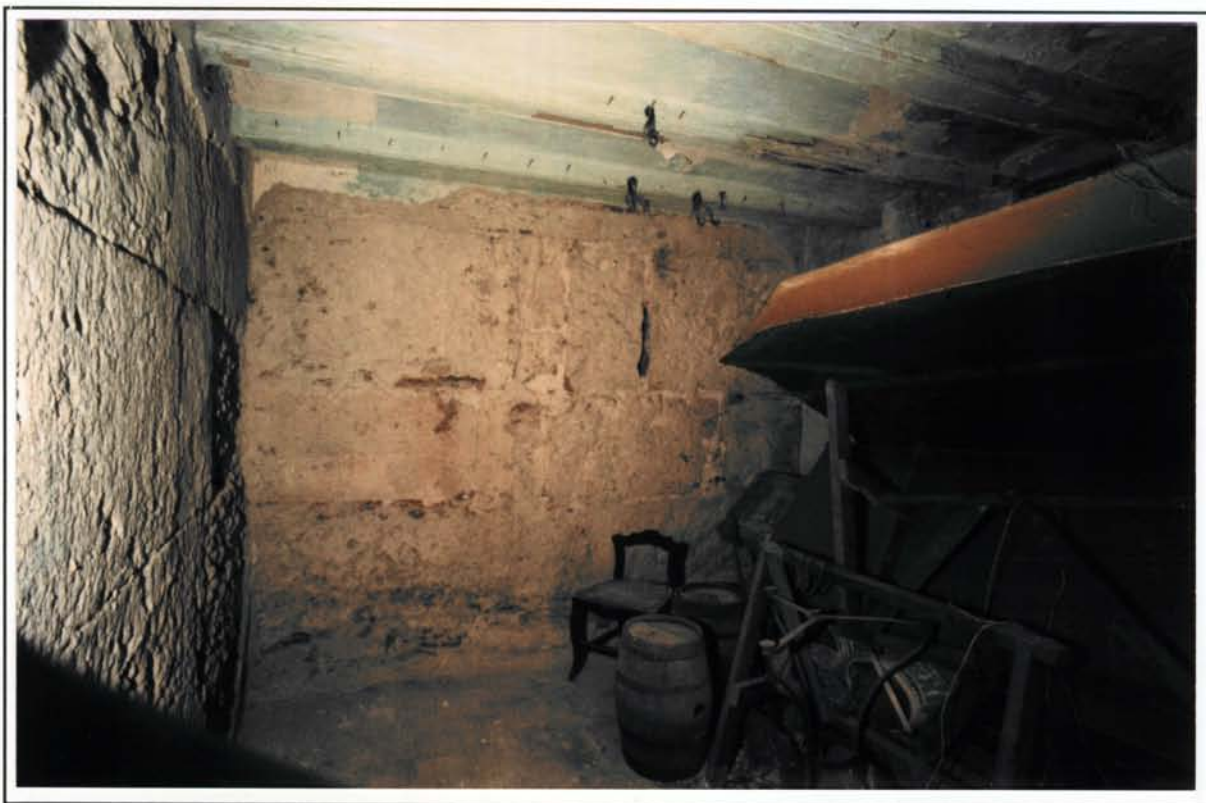
Foto 7. Planta entresol. Parament torre (foto R.Muro).
