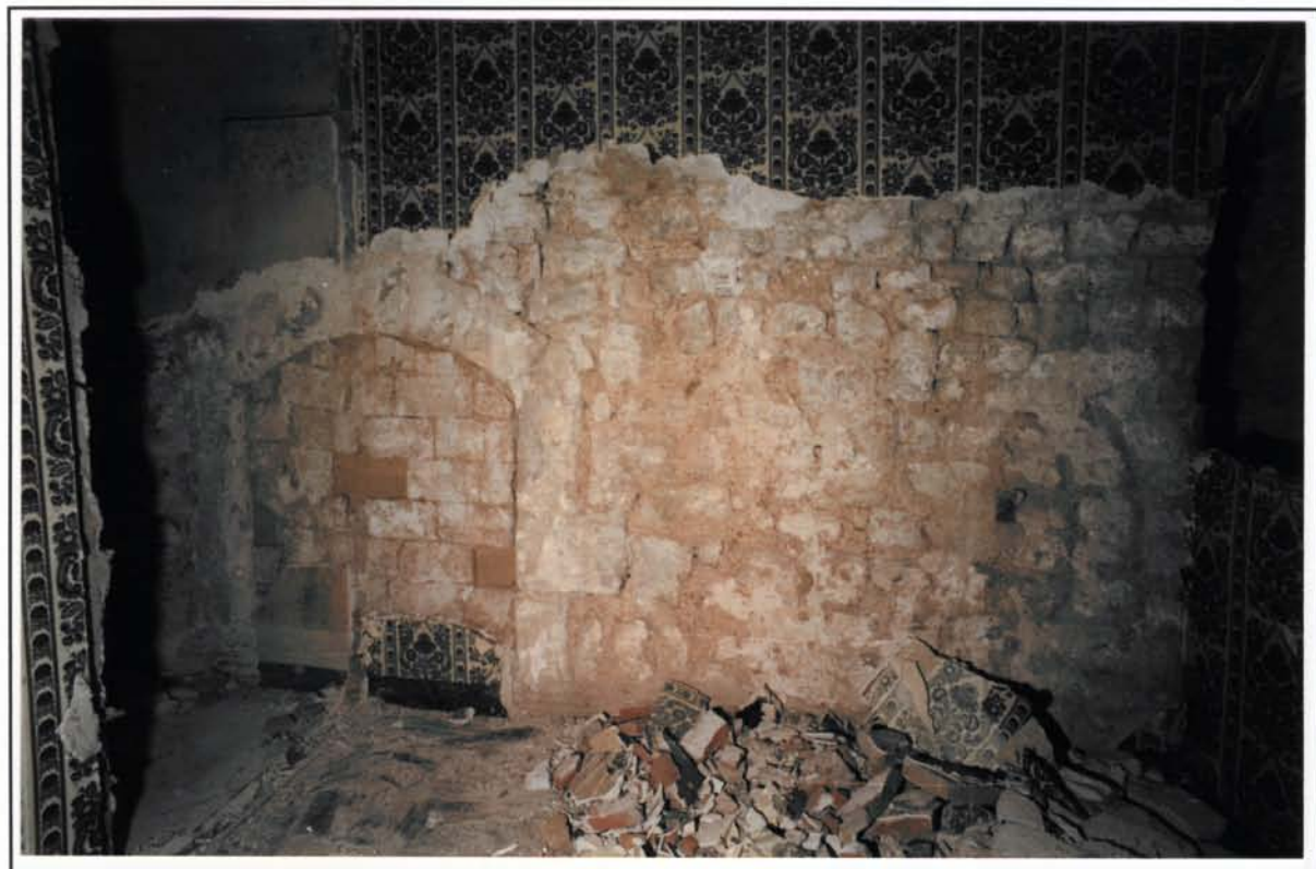
Foto 19. Planta primera. Parament contigüu Pati d'en Llimona (foto R.Muro).
