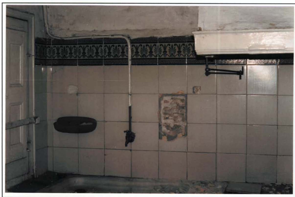
Foto 21. Planta segona. Cuina (foto E.Pagès).
