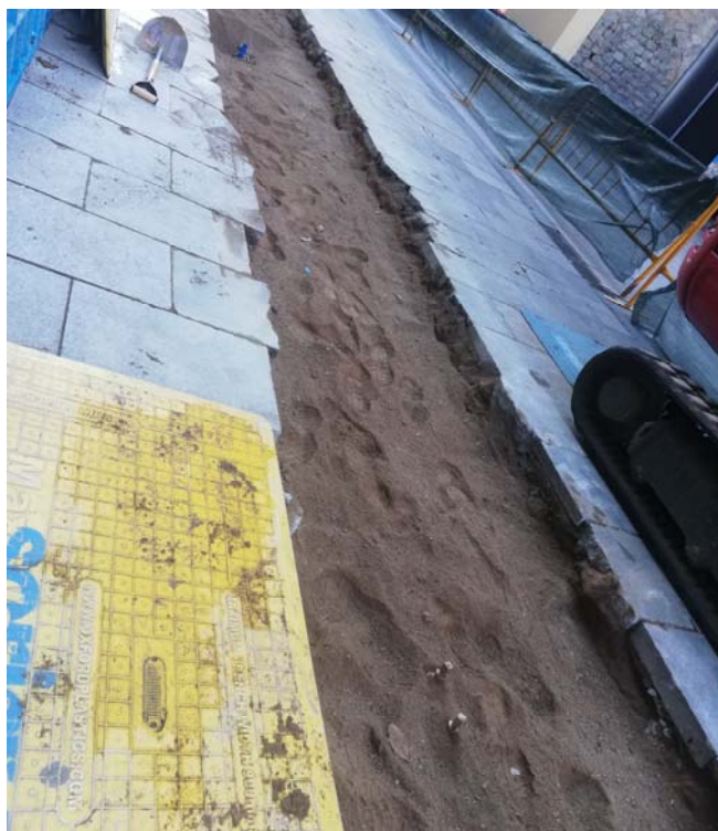
Fotografia 8. Farciment de la rasa amb sauló
