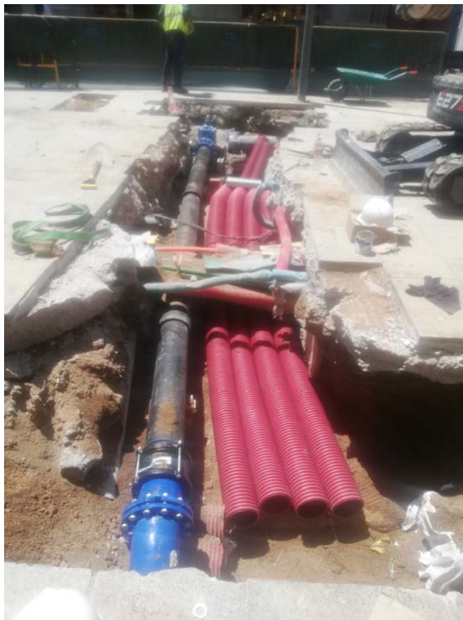
Fotografia 7. Col·locació de la nova xarxa de serveis
