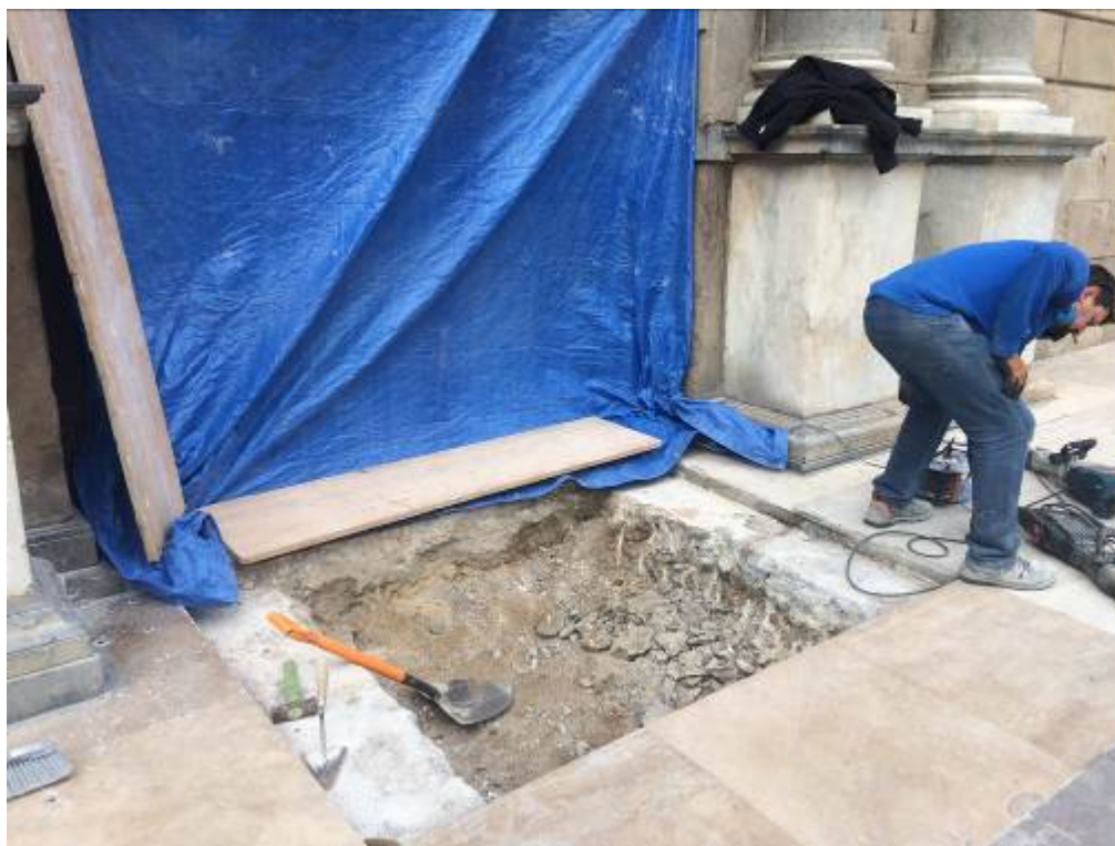
Extracció del formigó.
