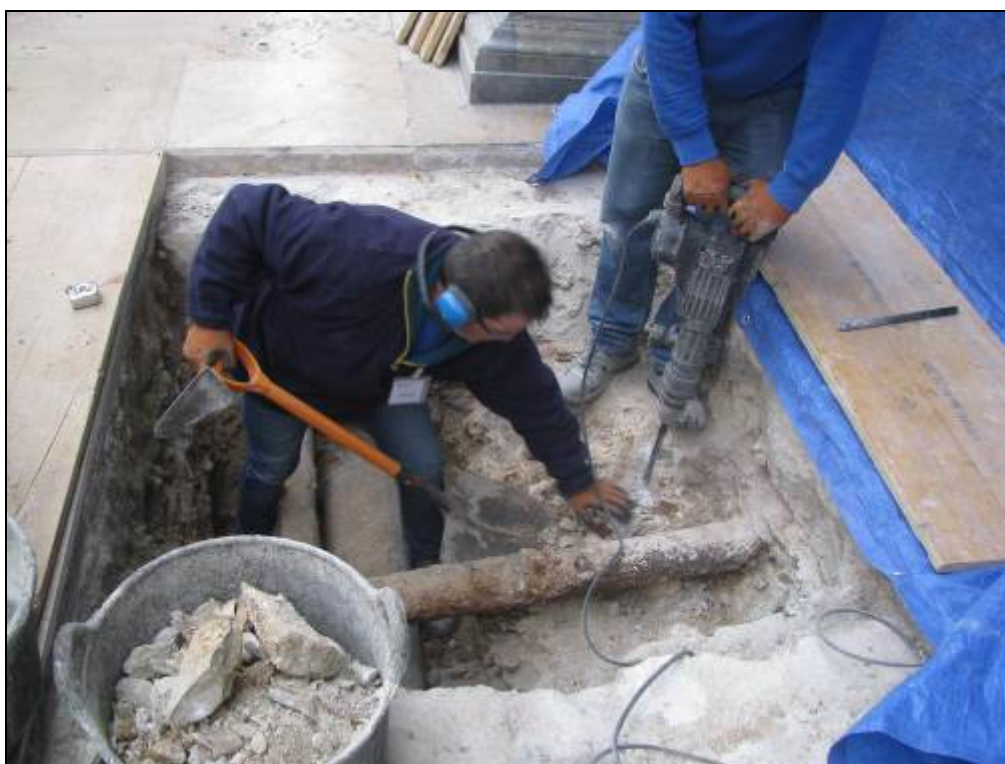
Inici dels treballs de desmuntatge de la part del mur afectat.
