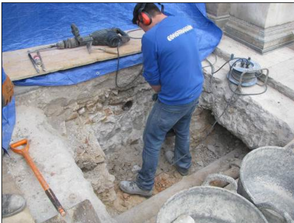
Feines de desmuntatge de la part del mur afectat.
