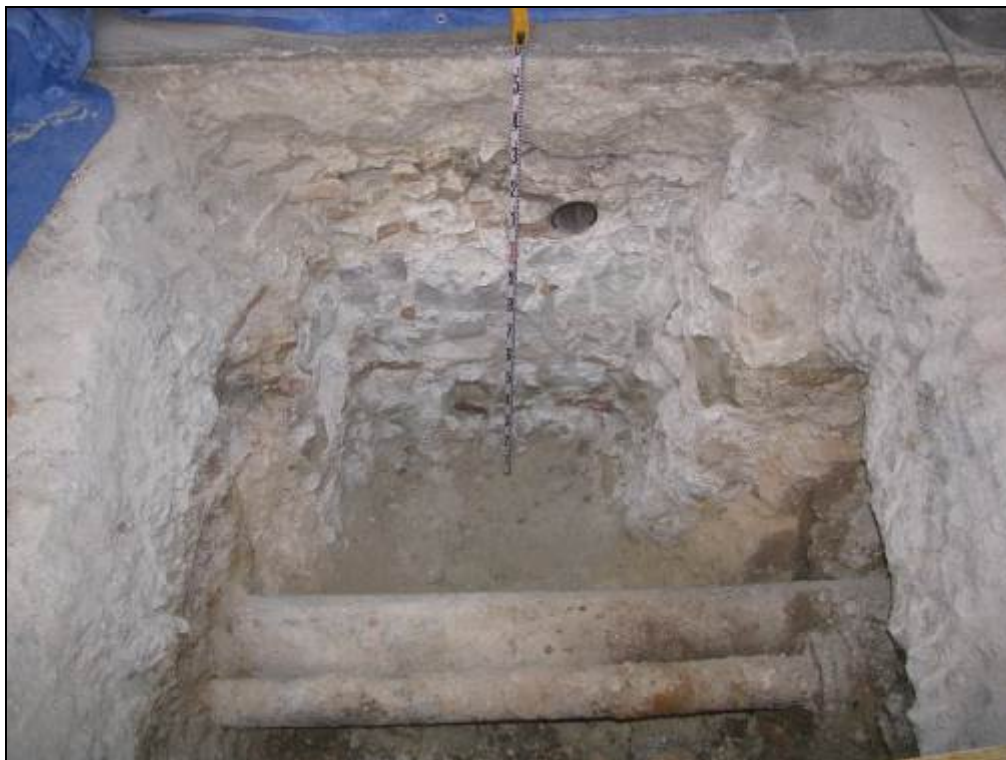
Treballs finalitzats un cop assolida la cota per instal·lar la piona retràctil.
