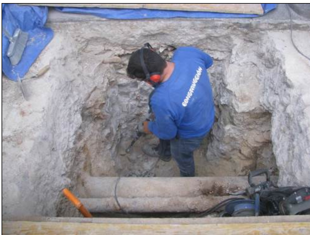
Feines de desmuntatge de la part del mur afectat.
