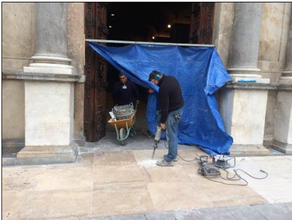
Inici dels treballs. Extracció de les llosses.
