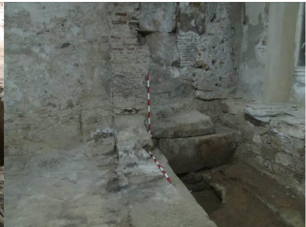
16. Vista de les restes del parament de la torre circular UE 08
