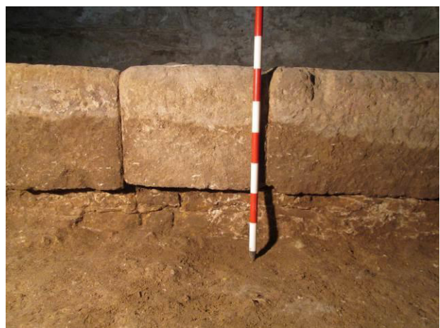
18. Detall del parament de la muralla UE01 amortitzant el mur UE28
