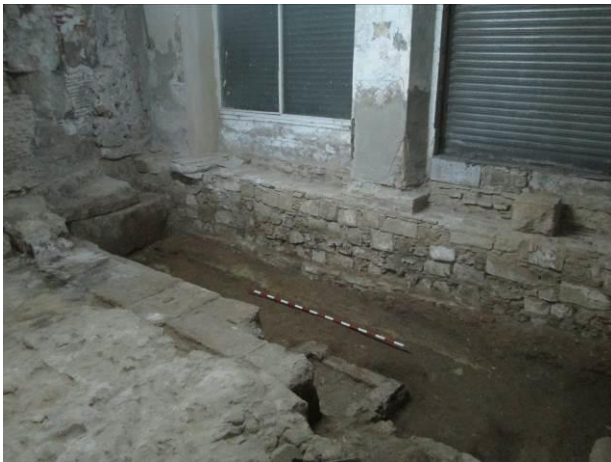
13. Vista general dels treballs d'excavació un cop assolida la cota necessària per l'obra.
