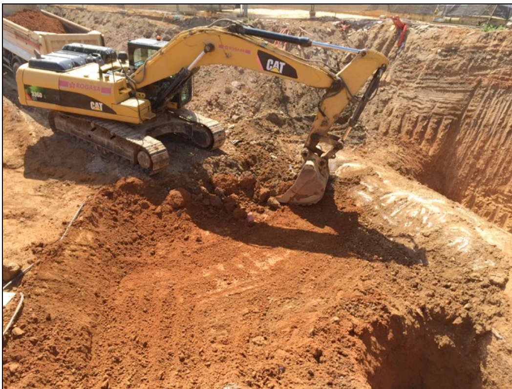
Fotografia 64. Rebaix del nivell geològic UE104 al sud del col·lector a desviar UE122.
