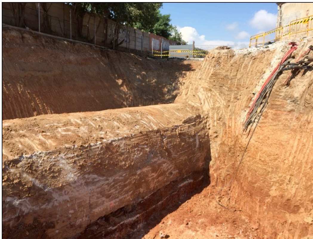
Fotografia 65. Vista general del col·lector de formigó a desviar UE122.
