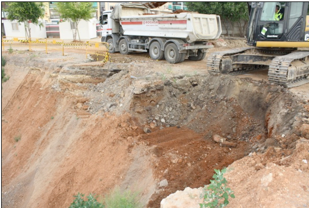
Fotografia 24. Inici rebaix sector sud de la parcel·la afectada.
