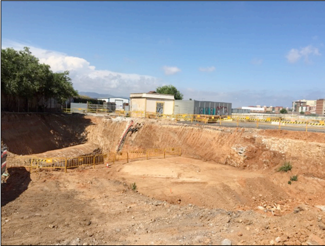
Fotografia 37. Vista general àmbit de la intervenció amb col·lector de formigó UE122 al fons i restes arqueològiques el segle XIX en primer pla. Vista nord-sud.
