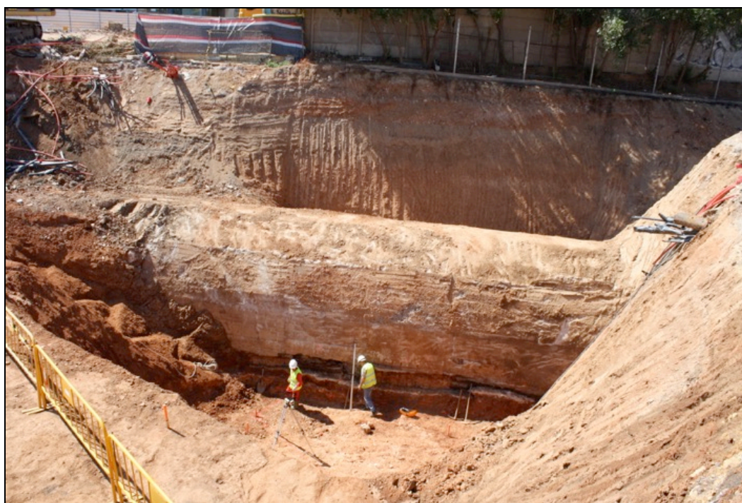
Fotografia 66. Treballs de desviament del col·lector existent UE122.
