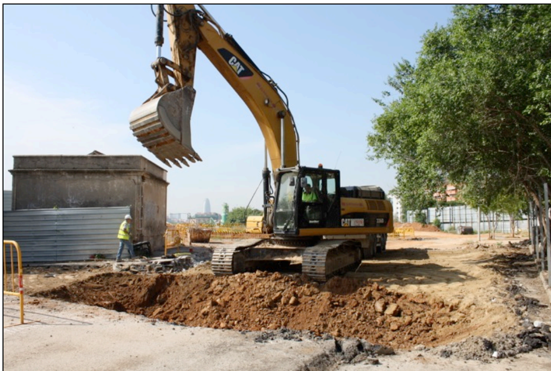
Fotografia 2. Inicis dels treballs de rebaix del subsòl a la zona nord de la rasa oberta. Aportacions de terres contemporànies, UE100.
