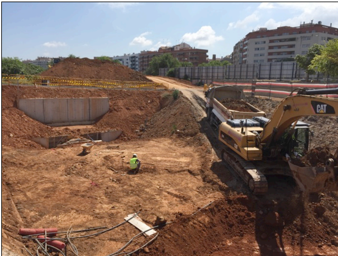
Fotografia 36. Procés d'excavació estructura UE112.
