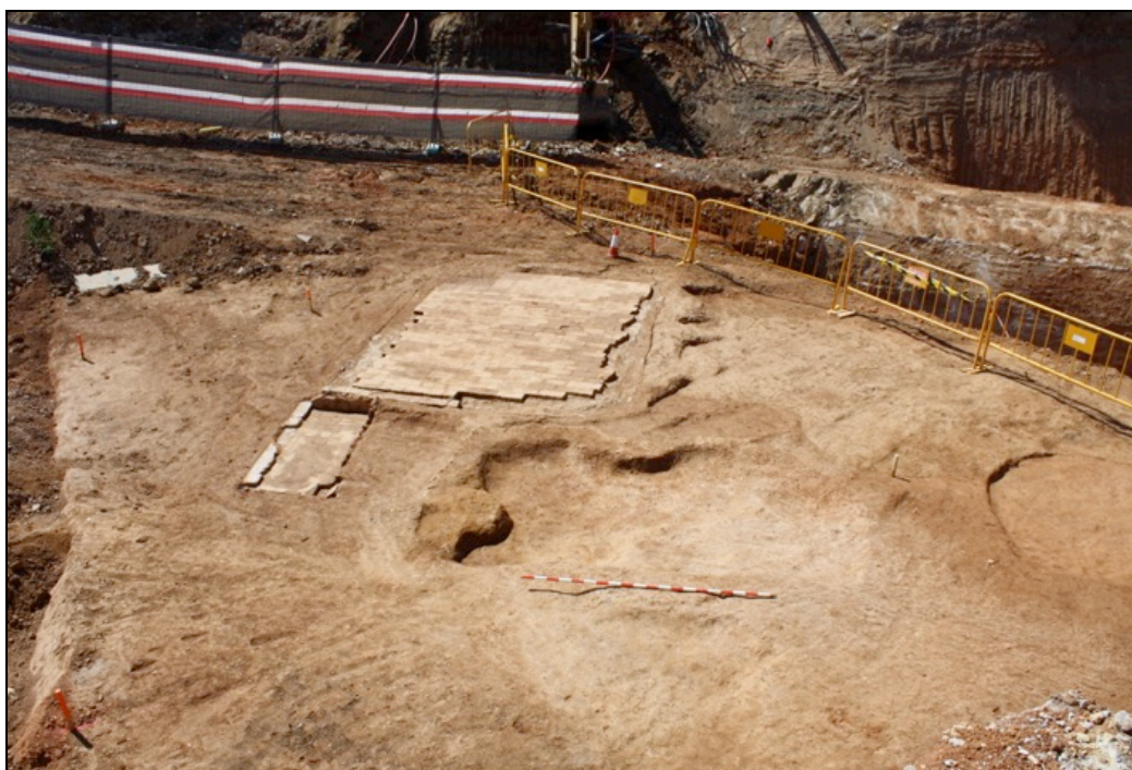
Fotografia 46. Retall UE115 un cop excavat.
