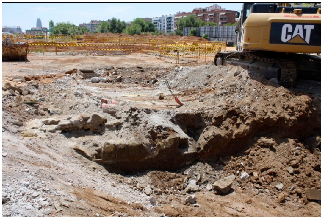
Fotografia 6. Localització restes d'un dels murs relacionats amb el Pont del Treball, UE124, amb restes del reblert del retall UE132.
