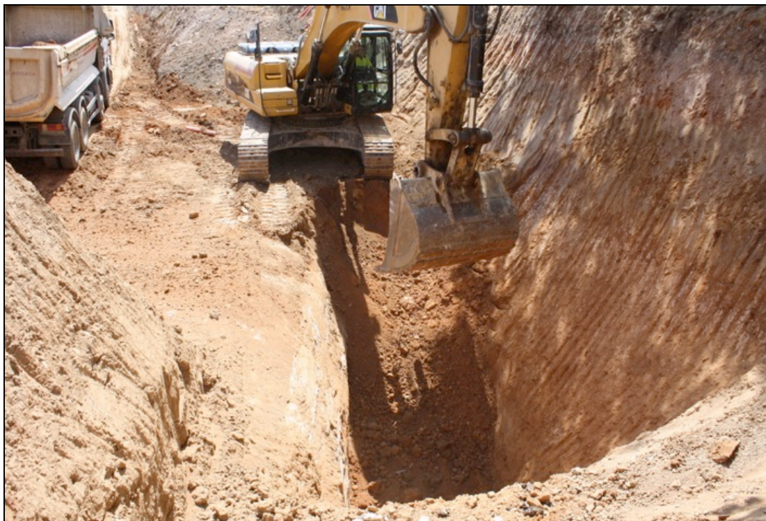
Fotografia 17. Rebaix nivell geològic UE104 al nord el col·lector UE122.
