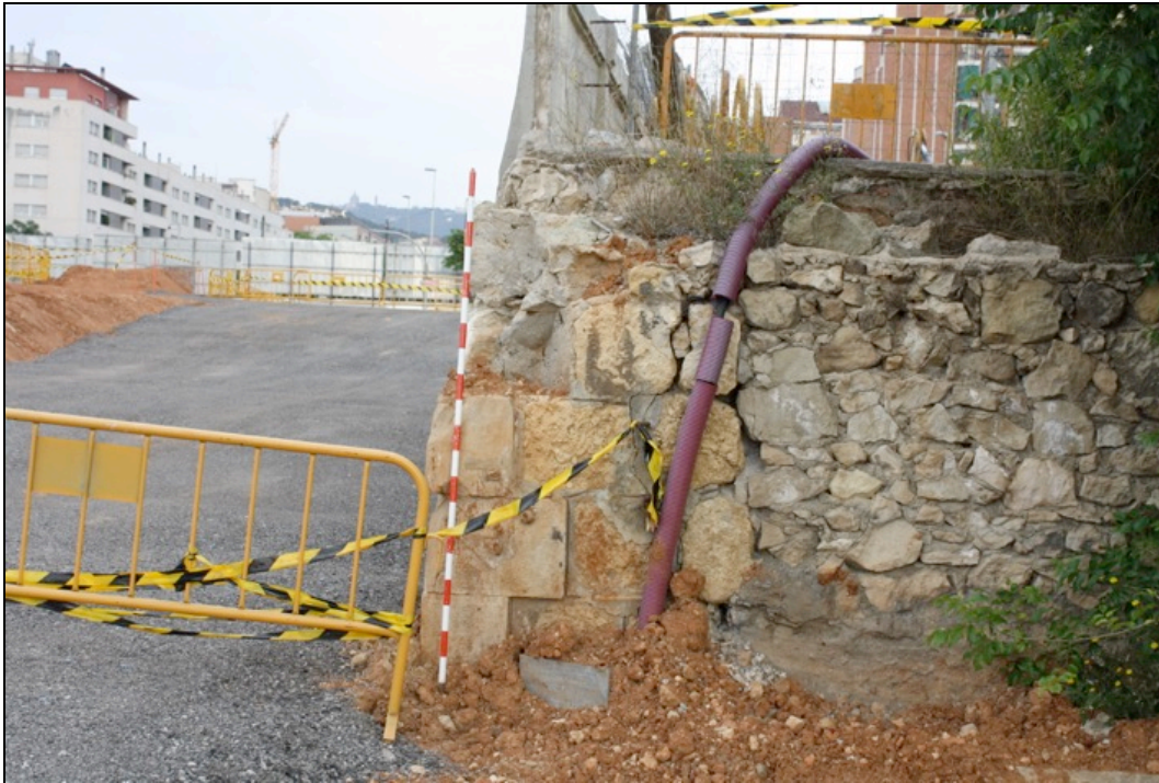
Fotografia 31. Detall d'una cantonada d'un dels murs encara dempeus del Pont del Treball fet amb pedres treballades i ciment pòrtland.
