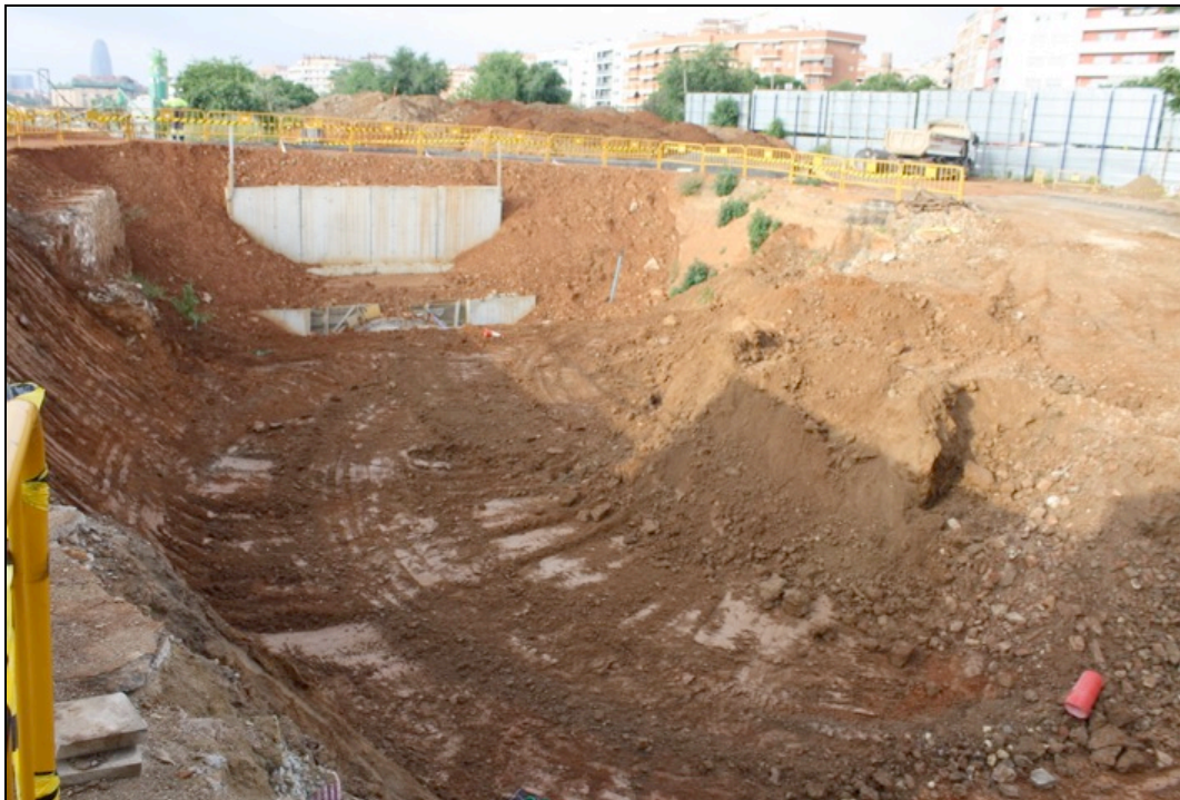
Fotografia 32. Vista general part central de la rasa oberta amb estrat de llims vermells datats al segle XX UE108.
