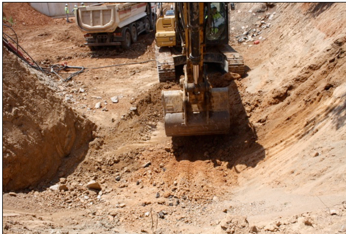
Fotografia 16. Localització col·lector de formigó UE122.
