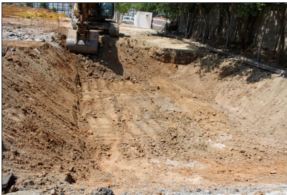
Fotografia 4. Rebaix de l'estrat UE 101.
