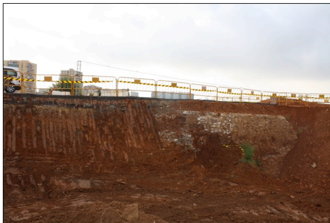
Fotografia 28. Tall estratigràfic tram sud de la rasa oberta amb restes del mur UE126 relacionat amb el Pont del Treball datat a inicis del segle XX.
