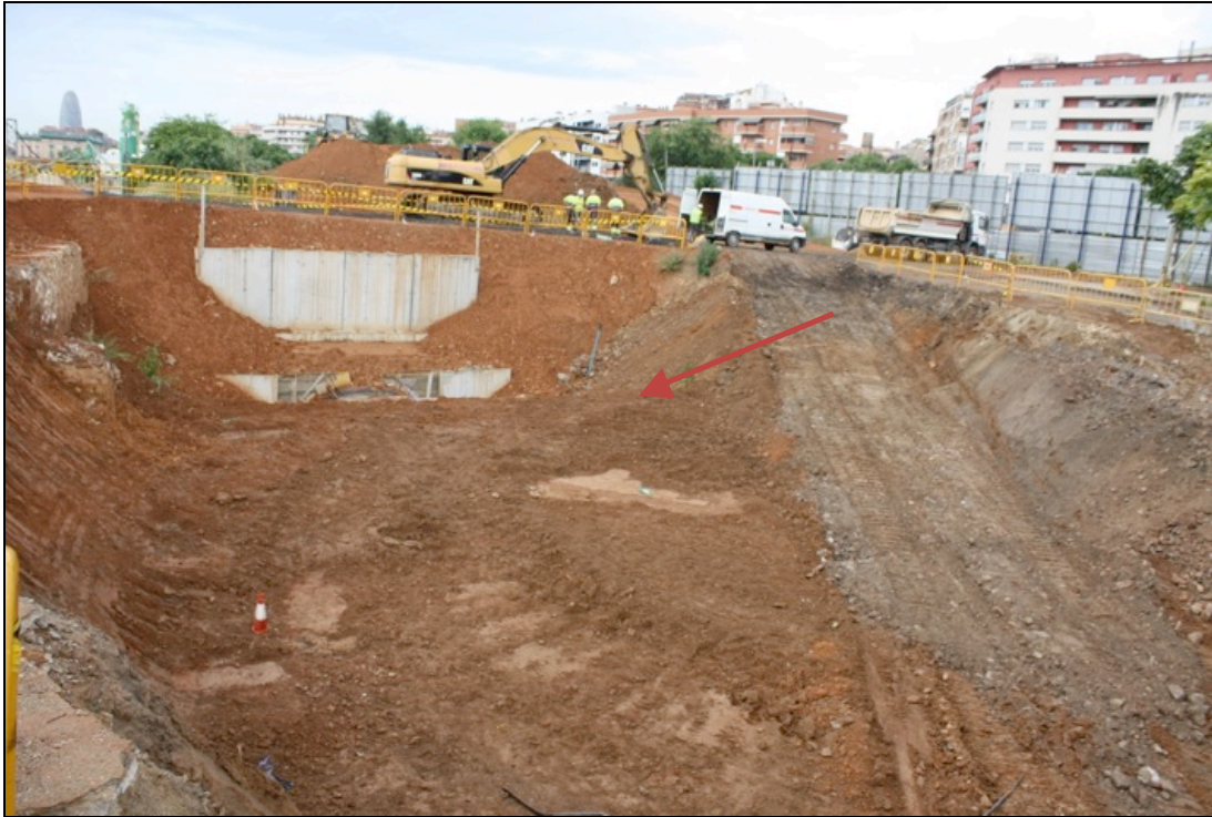
Fotografia 35. Vista general de l'àmbit sud de la rasa amb estrat UE109 i primeres restes estructures del segle XIX UE112.
