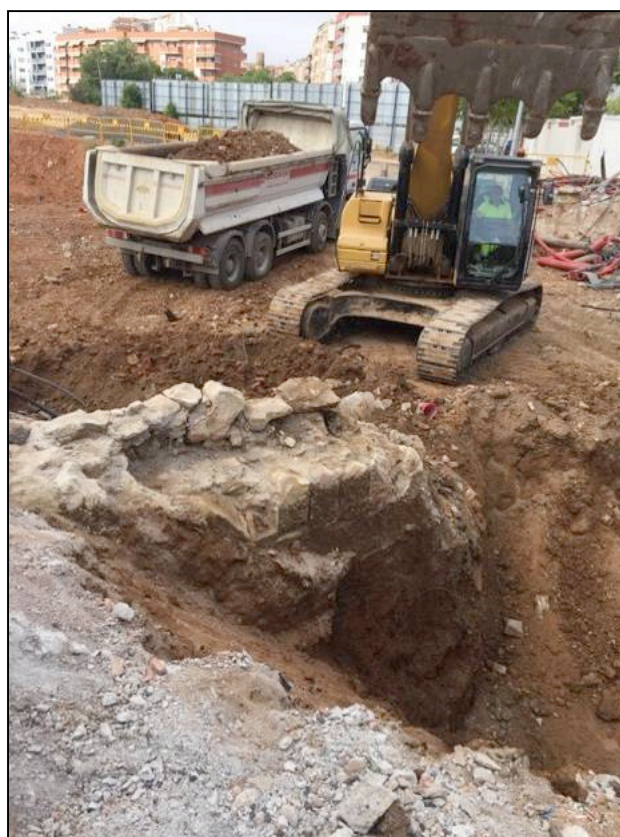
Fotografia 20. Vista en alçat mur UE 124. Construït amb pedres treballades i ciment pòrtland.
