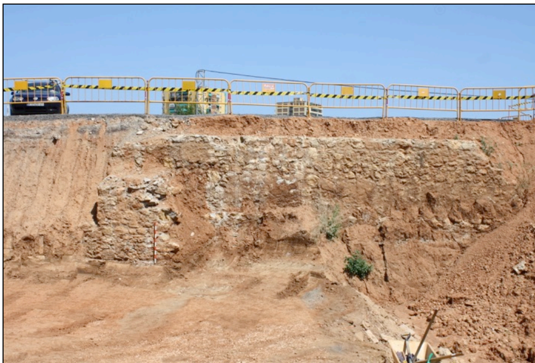
Fotografia 29. Vista de la part posterior del mur U126. Construït amb pedres i ciment pòrtland.
