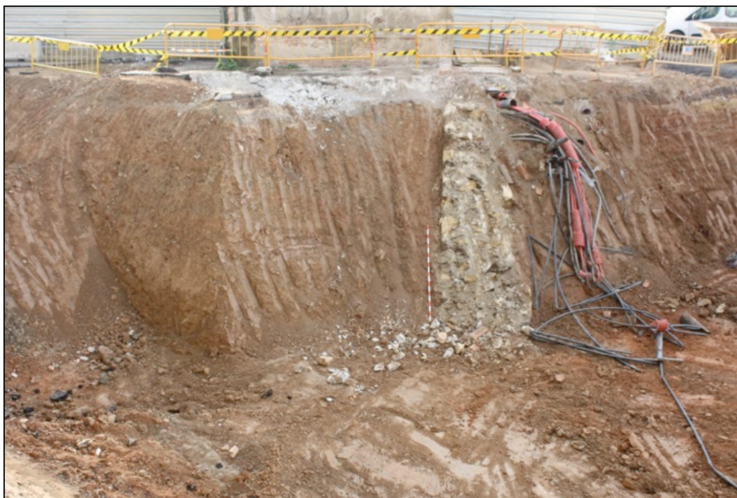
Fotografia 22. Tall estratigràfic zona nord de la rasa amb restes del mur UE124 juntament amb els serveis ja desviats.
