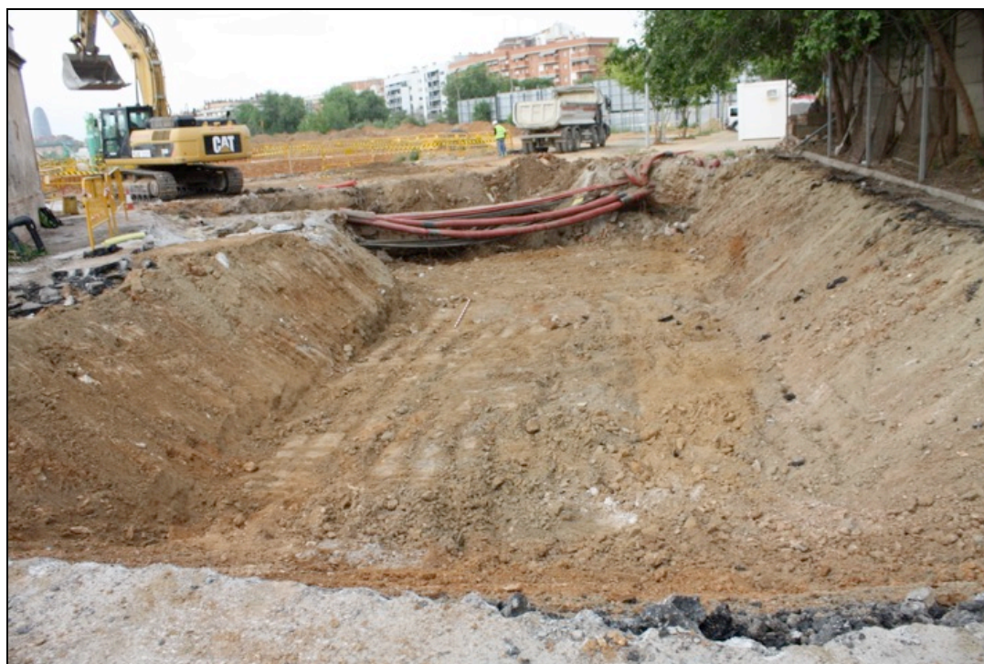
Fotografia 8. Vista general sector nord de la rasa amb UE103 i restes dels serveis ja en desús.
