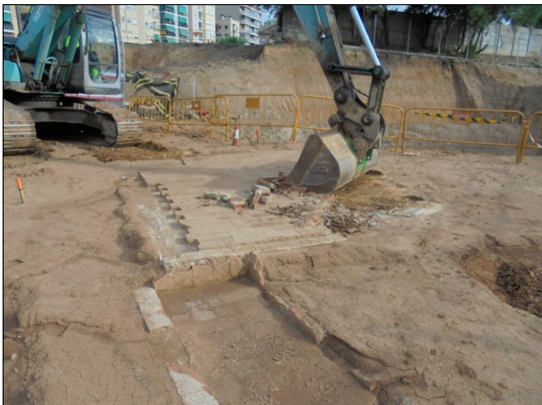
Fotografia 52. Desmuntatge estructures UE112 i UE14.
