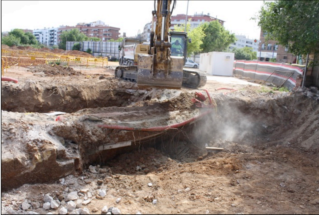
Fotografia 13. Rebaix de les terres contemporànies que rebleixen del retall UE132 juntament amb serveis existents fora de servei.
